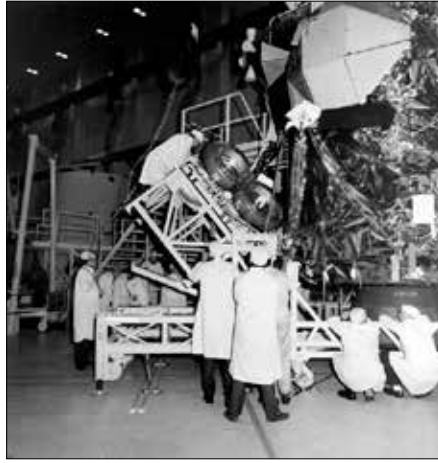
So wurde der zusammengeklappte Mondrover seitlich an die Landefähre angeflanscht (07f58720).
